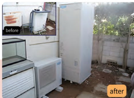
ボイラーからエコキュートへの交換工事
