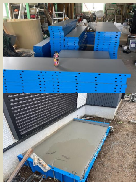
受注対応力強化を図る基礎鋼製型枠導入
